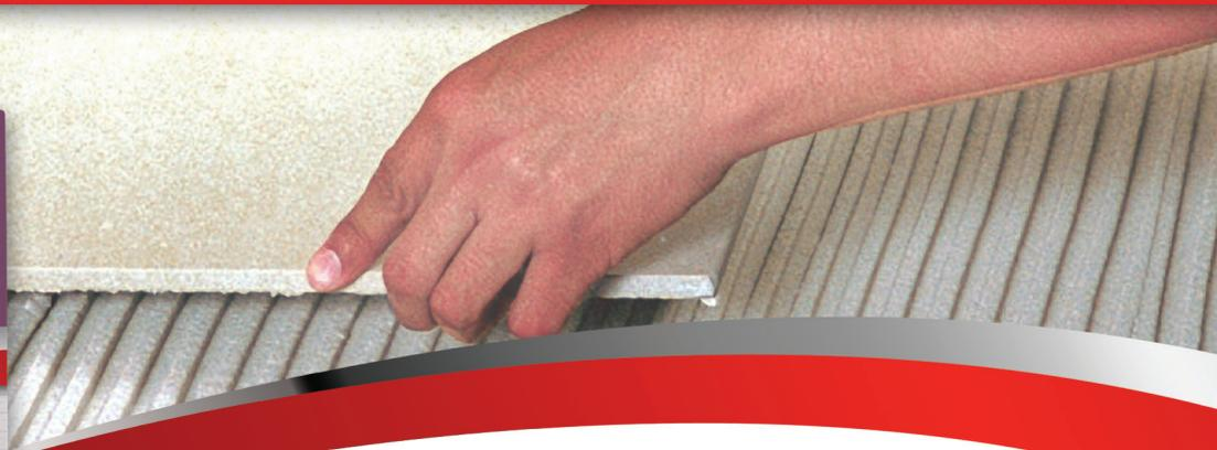
Adhesivo base cemento modificado con resinas en polvo, que incrementa la adhesividad. Especialmente diseñado para la colocación de piezas de nula absorción de humedad [loseta porcelánica] y piedras naturales. Cumple y excede ANSI A 118.4
